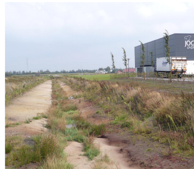
ill. 5.2 Regnvandsgrøft, Ribe Erhvervsområde Øst.
